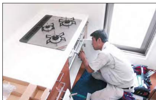
リフォーム工事は、自社エンジニアが行う。訪問するのは工事実施の当日だけだ。
